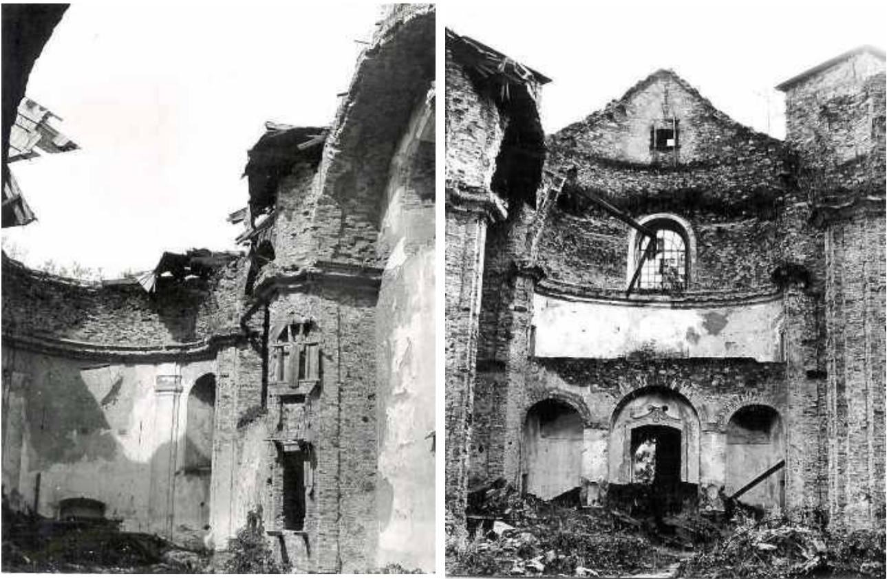
Blick zum Hauptaltar und Haupteingang nach der Herunterstürzung des Daches am Ende der 60-ten Jahren, Zustand in 1792.
