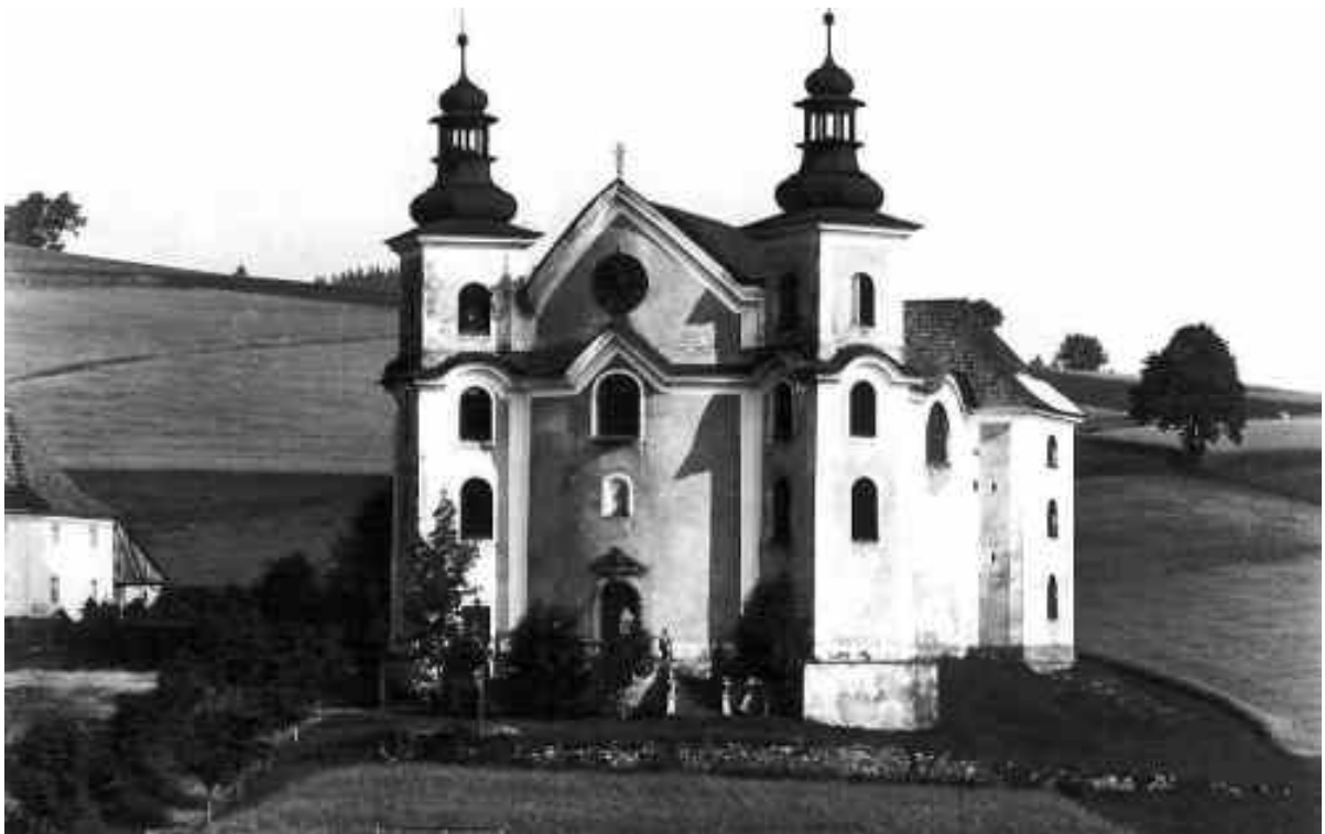
Fassade der Kirche vom Südosten. 30-te Jahre des 20. Jh.
