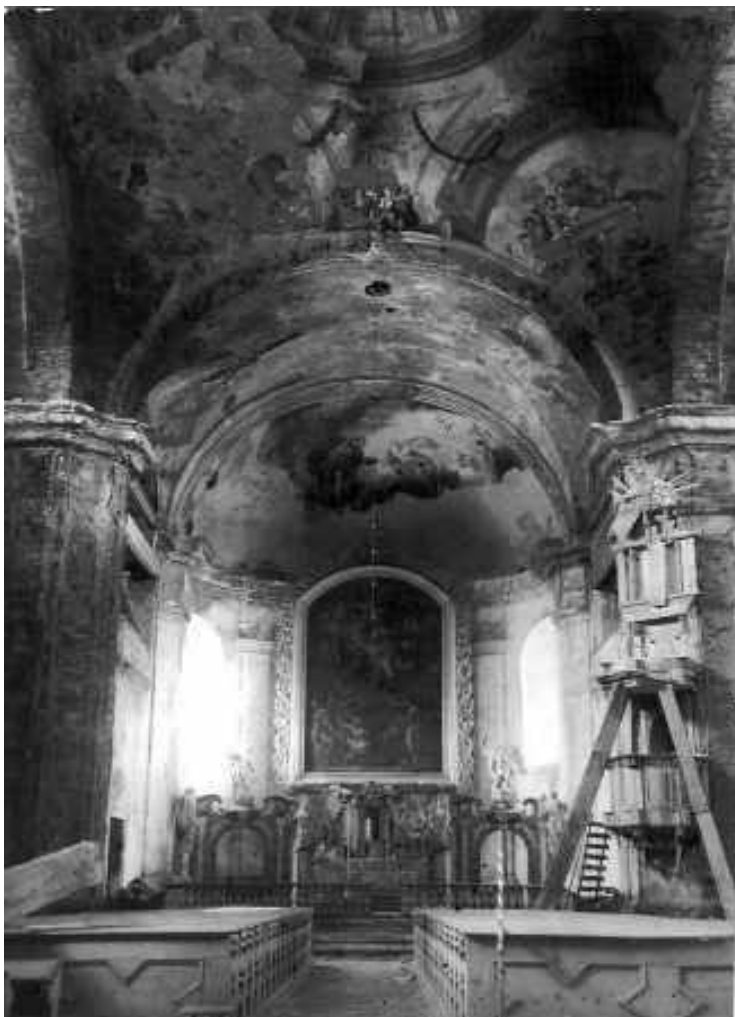
Zustand des Inneren um 1955.
