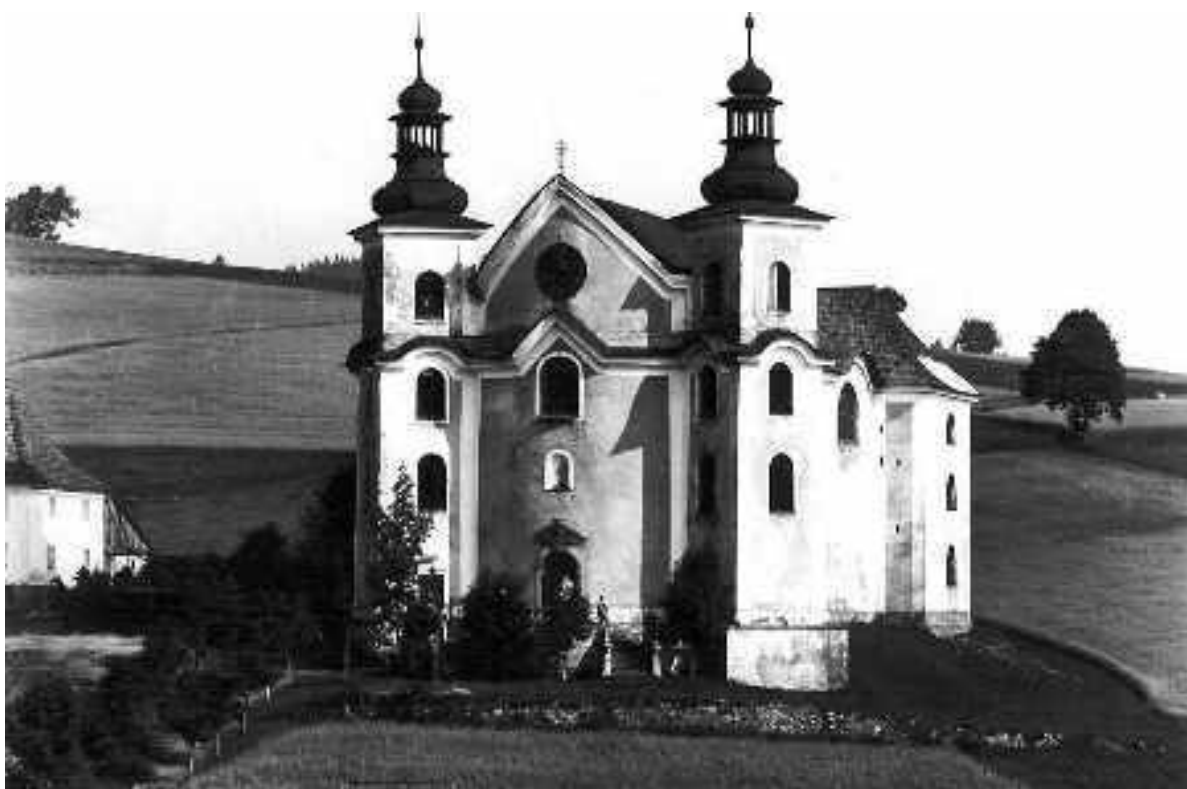
Průčelí kostela od jihovýchodu - třicátá léta 20. století.
